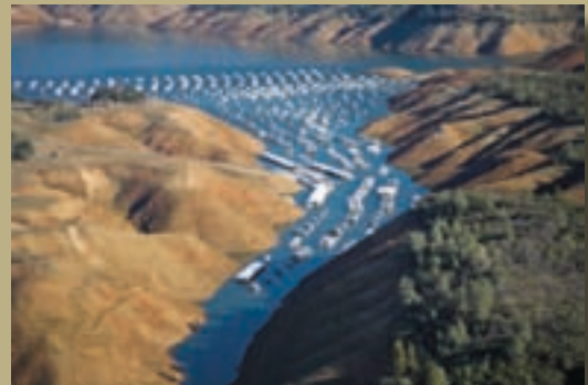
Oroville Lake Feb. 2009
